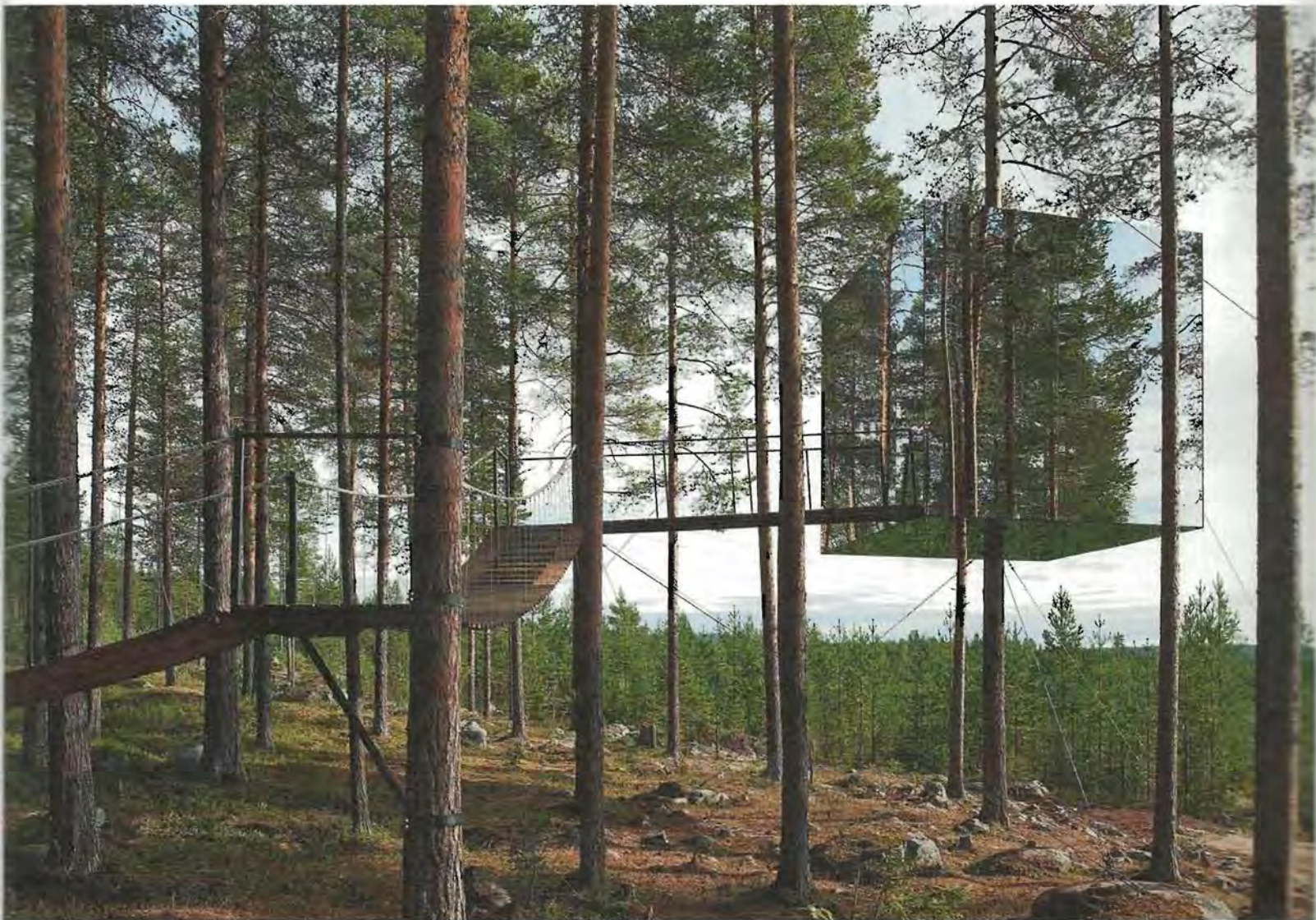
Tree Hotel in Harads/S: Die Spiegelflächen vermitteln zwischen exakter Geometrie und wilder Natur.
